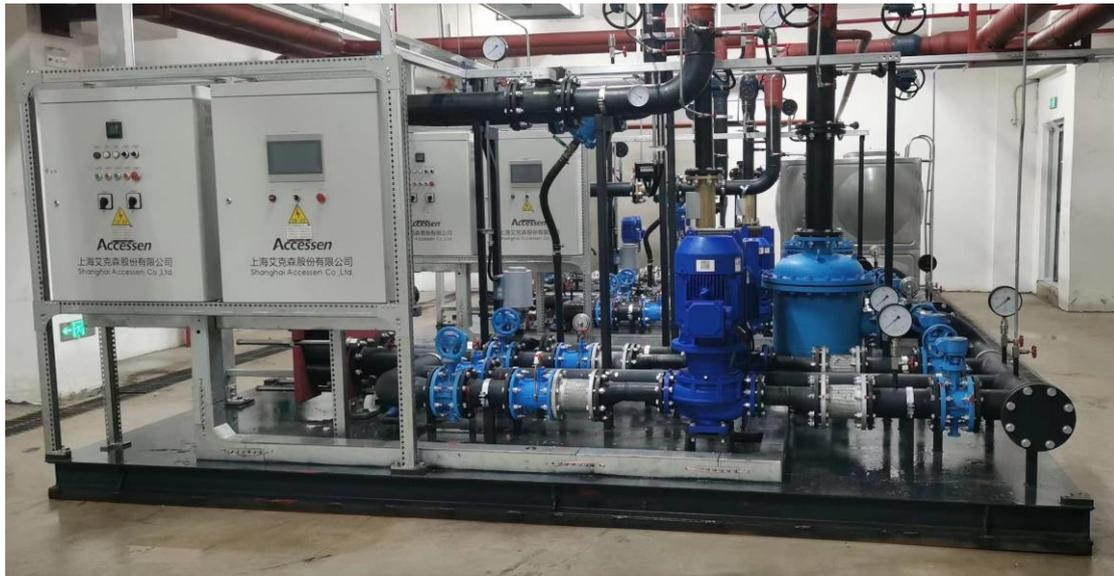
艾克森 GU-ADRP 系列全工况高效换热机组，可以在设计额定工况安全稳定运行的基础上，能够在运行时间占很大的部分负荷工况下，实现可调可控变工况运行，在低负荷时也能保持很高的能效。低阻力管路设计结合电泳工艺让机组管路畅通无阻，减少能耗损失。优秀的过滤性能和抗污垢堆积性能，极大的降低运行中过滤器段带来的循环阻力。最新的高速控制模块的硬件核心，二次循环泵组以高效运行为目标，控制系统自动制定和控制泵组运行组合和运行频率，保证二次侧水力平衡前提下，水泵常态处于高效区运行，还有多种流量和温度控制方式可供客户自行选择，助力用户实现精准供热，提高能源的利用率，为供热用户提供更多选择和供热解决方案，成为你的安心选择。
